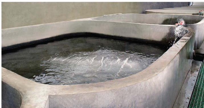
Khu vực cần thi công.
