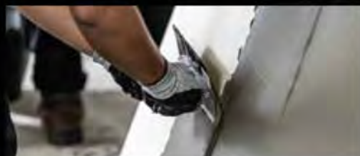
5. ใช้เกรียงหัวด้านเรียบปาดกาวยึดลงบนพื้นหรือผนังที่ต้องการปูกระเบื้องให้ทั่ว ใช้เกรียงหัวปาดกาวยึดให้เป็นร่อง โดยทำมุม 45 องศา ปาดในทิศทางเดียวกันกับด้านสันของกระเบื้อง
