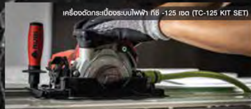
2. ใช้เครื่องตัดกระเบื้องระบบไฟฟ้า ตัดกระเบื้องให้ได้ตามขนาดที่ต้องการ
