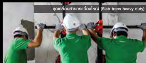
6. ใช้ชุดเคลื่อนย้ายกระเบื้องใหญ่ ยกกระเบื้องวางในตำแหน่งที่ต้องการติดตั้ง บรรจระดับโดยใช้อุปกรณ์จัดแนวกระเบื้อง ใช้ค้อนยางเคาะบนกระเบื้อง จากนั้นจึงทำการยาแนวร่องกระเบื้อง
