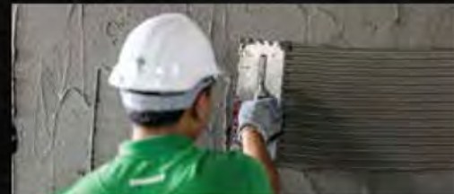
4. ใช้เกรียงหัวด้านเรียบปาดกาวยึดลงบนพื้นหรือผนังที่ต้องการปูกระเบื้องให้ทั่ว ใช้เกรียงหัวปาดกาวยึดให้เป็นร่อง โดยทำมุม 45 องศา ปาดในทิศทางเดียวกันกับด้านสันของกระเบื้อง
